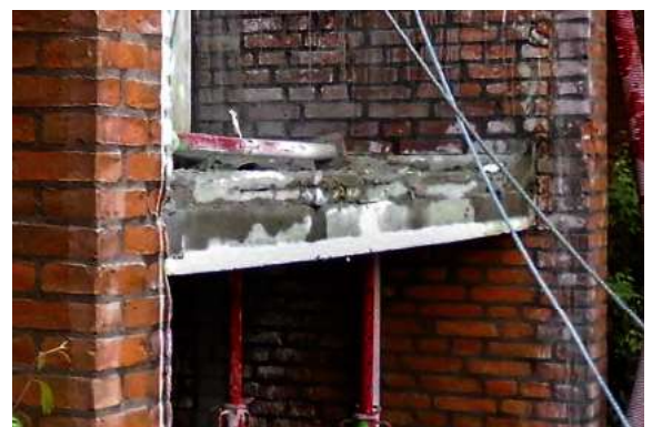
Fremspringet på facaden gjorde det vanskeligt at få stilladset tæt på
